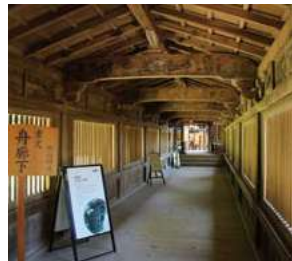
寶嚴寺 船廊下(重要文化財) 據傳是使用豐臣秀吉的船「日本丸」的望樓而建成。(寬約1.8公尺、長約30公尺)
